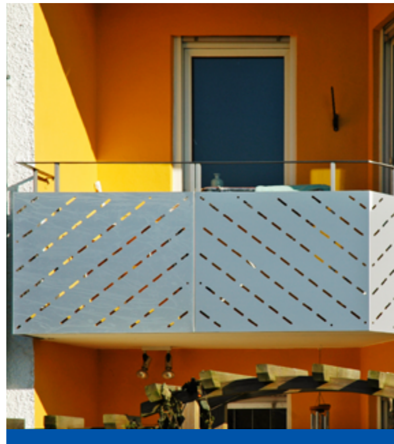
Balkonfüllung nach Kundenwunsch gestanzt aus 2 mm AL-Blech eloxiert E6EV1
